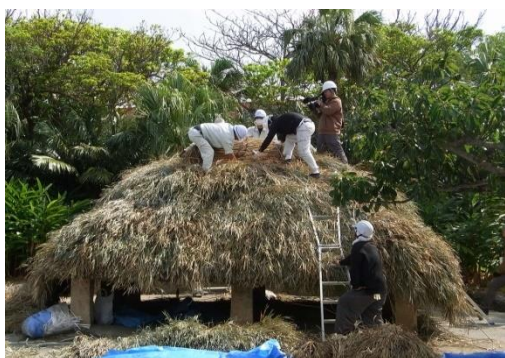
※写真は平成27年度に行われた茅葺屋根の修繕の様子
